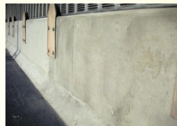
GC-13樹脂モルタル塗り完了
