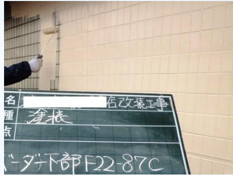
GC-500施工後色塗装
