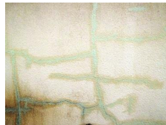
GC-500にて亀裂補修
