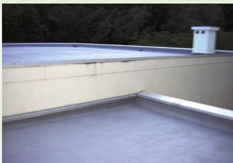
屋上防水： GC-100塗布後、上塗り塗料で仕上げ
