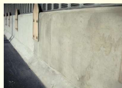
GC-13樹脂モルタル塗り完了
