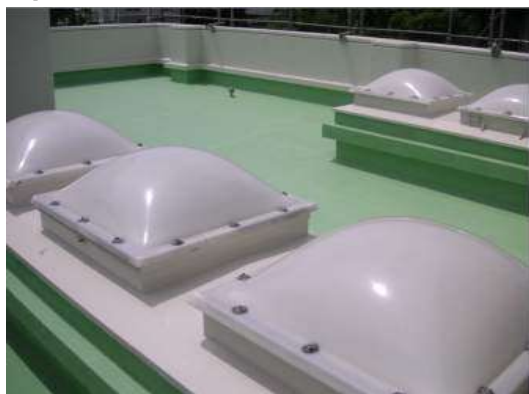
滋賀県 ○邸(屋上トップライト)
